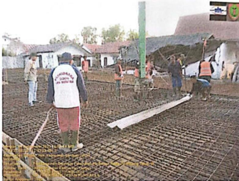
PEKERJAAN PENGECORAN BALOK, BALOK FENDER & LANTAI DERMAGA
